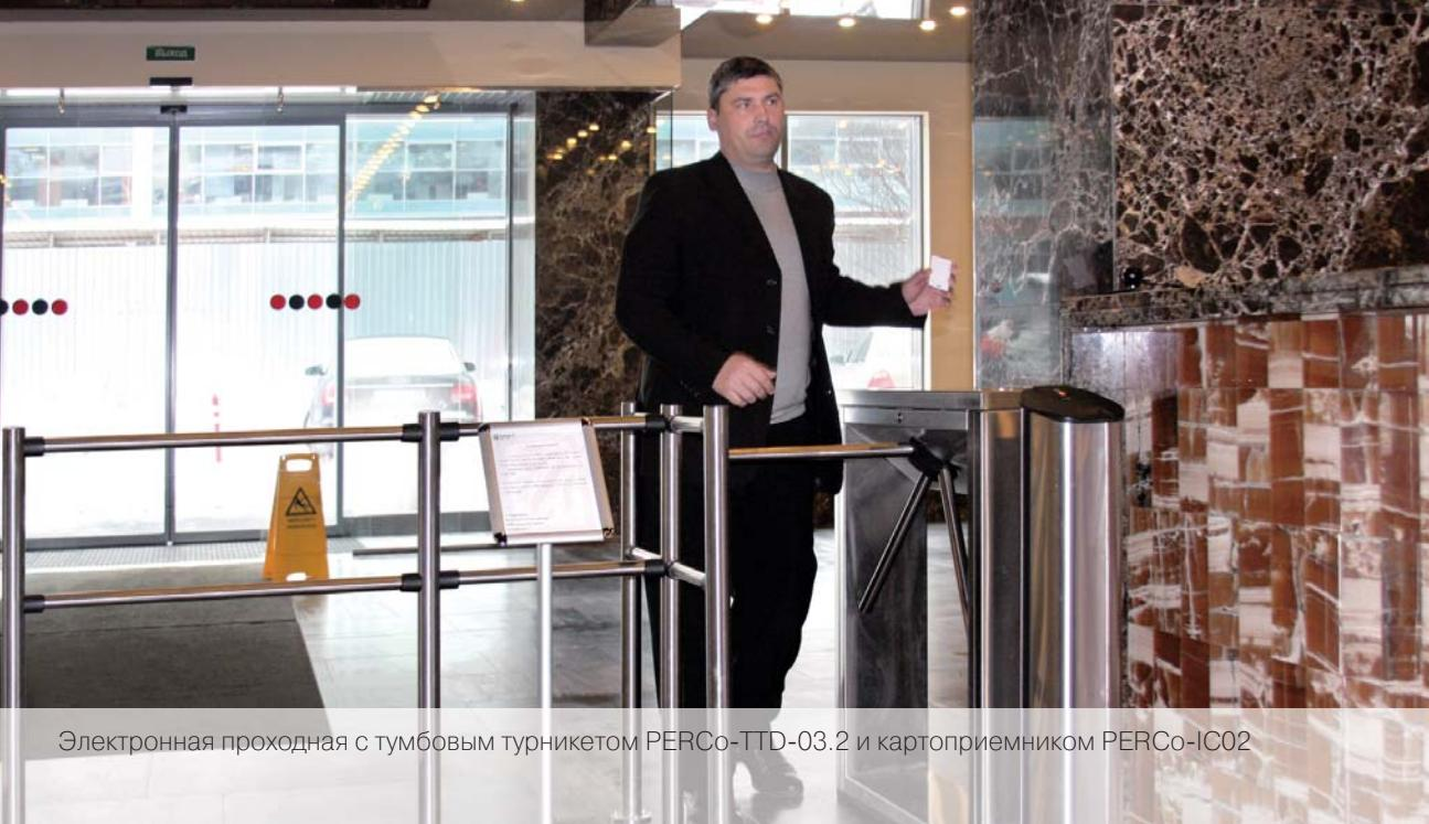
Электронная проходная с тумбовым турникетом PERCo-TTD-03.2 и картоприемником PERCo-ICQ2
